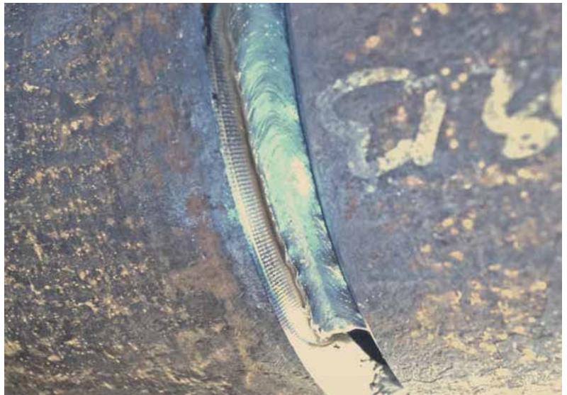
IAC - Faldende svejsning af rodsøm i fjernvarmerør. Hastigheden er væsentlig forøget i forhold til traditionel stigende svejsning.
